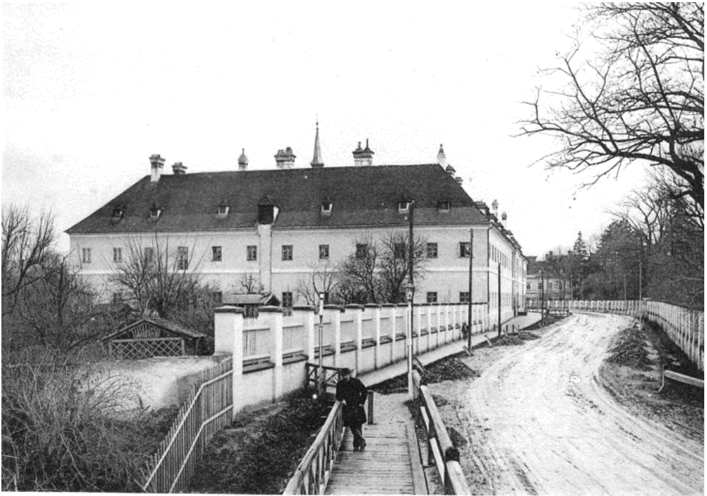
DIE K. K. FORSTLICHE VERSUCHSANSTALT IN MARIABRUNN. ANSICHT DER OST- UND NORDSEITE.
