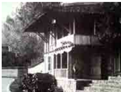
Фиг. 1. Жеравненска къща с широка стреха, предпазваща стените от силно навлажняване
