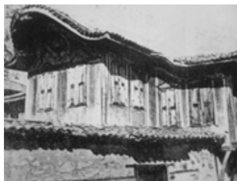
Фиг. 9. Барокова кобилица в Копривщанска къща, покрита със стари керемиди („турски керемиди“)
