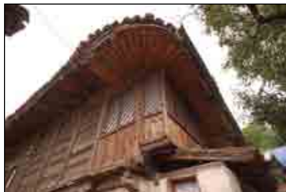
Фиг. 4. Извита стреха с дъсчена обшивка – Копrivщeнcкa къщa
