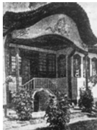
Фиг. 8. Покриване със стари керемиди (Копрившица)
