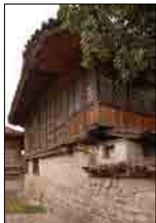
Фиг. 3. Извита стреха с дъсчена обшивка отдолу – Копrivщeнcкa къщa
